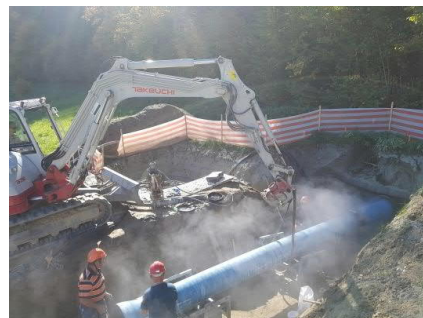
Spülbohrung Rütihoger: Rohreinzug Gussleitung GD 400 mm
