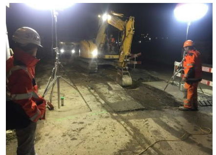
Nachtarbeiten zur Querung der Kantonsstrasse
