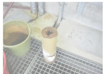
Faulwasserabzug mit starken Ablagerungen, so dass ein Abzug kaum mehr möglich ist
