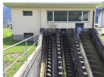
das bestehende Hebewerk, einzig verbleibendes Anlageteil
