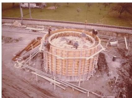
Faulturm im Bau ca. 1970
