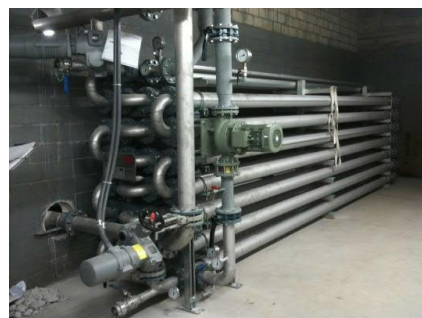
Beispiel eines Rohabwasser-Rohrbündelwärmetauschers
