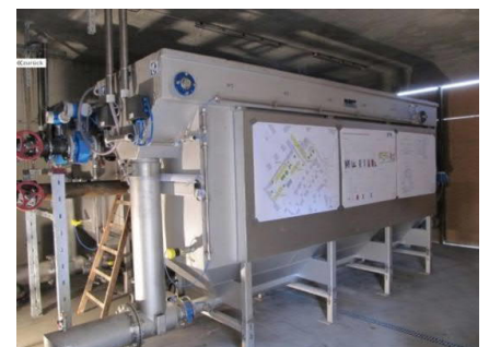
Beispiel eines Abwasserwärmetauschers in Behälterform
