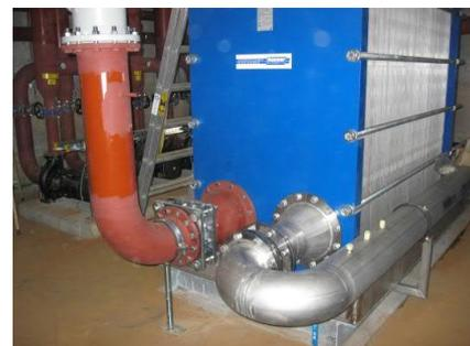
Beispiel von Plattenwärmetauschern Free-Flow, wie sie in Yverdon geplant sind
