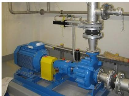
Beispiel Abwasserpumpen für die Abwasserwärmenutzung und Förderung von Abwasser am Beispiel Brünnen-Bern
