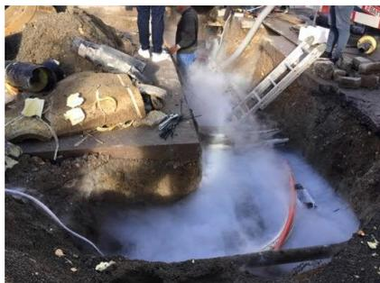
Einbindung der neuen Leitung ins bestehende Netz: Die bestehende Leitung wurde mittels liquidem Stickstoff eingefroren, gekappt und die neue Leitung eingebaut
