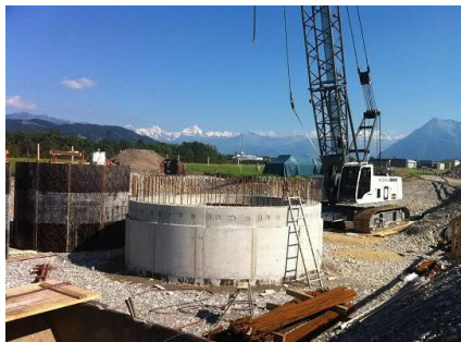
Absenken des Zentralschachtes
