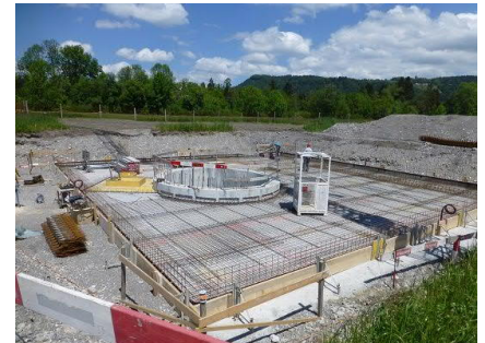
Bau des Gebäudes
