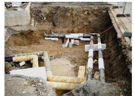
Hausanschluss und Abgang Netzfortsetzung mit vertikaler Etage
