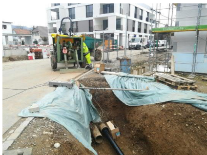
Vorbereitung Rohreinzug CASAFLEX durch Stahlrohr
