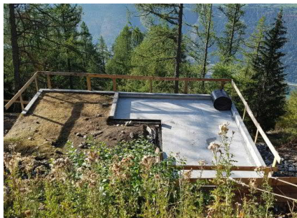
An das bestehende Reservoir Tatz wurde ein neuer Trinkwasserbehälter und Technikraum angebaut
