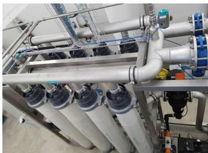
Standardisierte Ultrafiltrationsanlage CS 8 der Fa. Membratic SA mit insgesamt 8 Modulen und einer Filterfläche von 512 m<sup>2</sup>. Ein UF Modul enthält mehr als 16'000 Hohlfasern aus Kunststoff.
