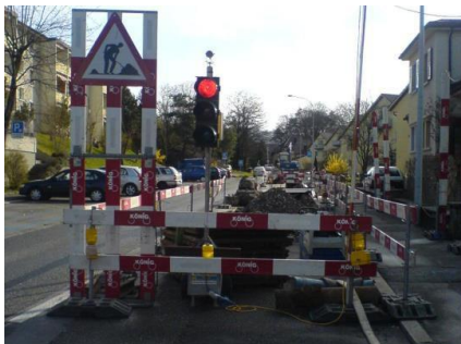
Die Sicherheitsvorkehrungen sind oberstes Gebot der Bauleitung
