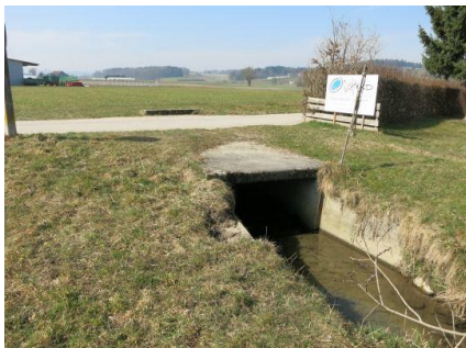
Unterquerung Brüelbach unter Brücke
