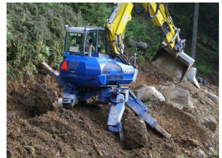
Grabarbeiten in steilem Gelände
