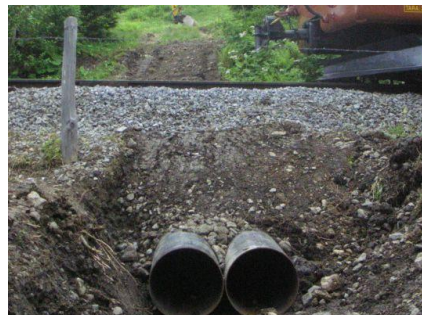
Querung der Bahnlinie mit Schutzrohren
