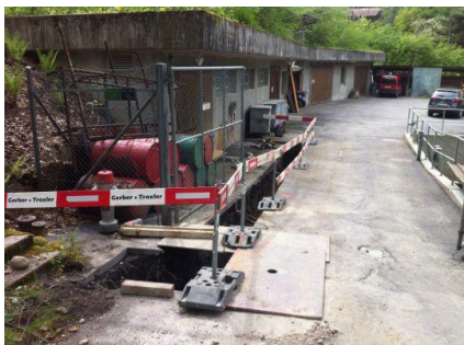
Leitungsbau Zu- und Ablaufleitung
