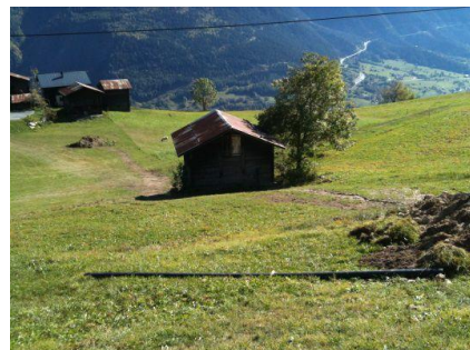
Bereits zugedeckter Leitungsbau nach Wyde (Gebäude am linken Bildrand)
