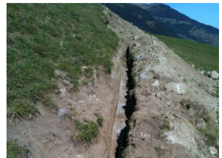
Grabarbeiten im Hang
