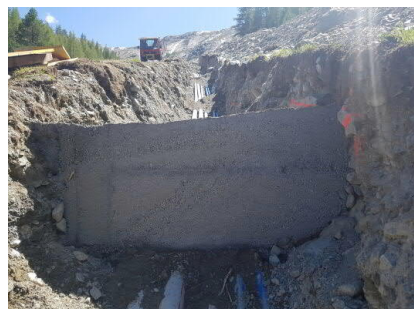
Betonriegel im Steilhang
