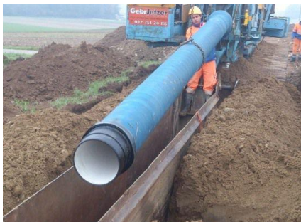
Fräsen mit Gleitspülung für die Rohrmontage
