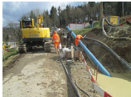
Spülbohrung: Rohreinzug mit laufender Montage
