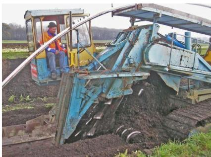
Grabenfräse mit Zugschalung
