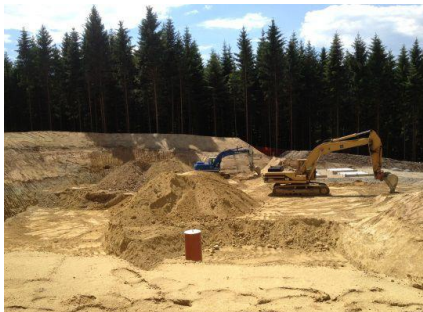
Aushubarbeiten im Frühjahr 2013
