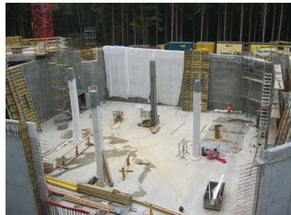
Betonarbeiten der Behälterwände Kammer 2
