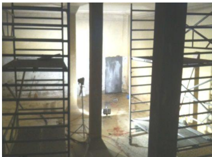
Sanierung der Becken nach dem Sandstrahlen
