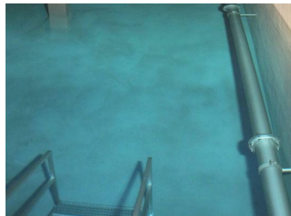
Sanierter Behälter mit neuer Zugangstreppe und neuen Grossrohrinstallationen
