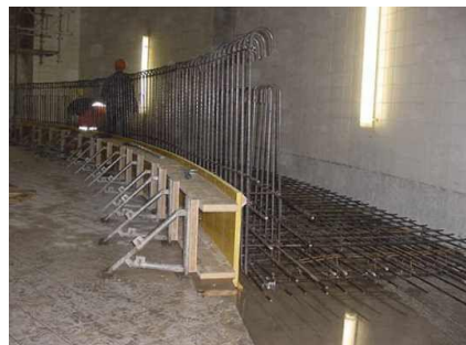
Konvexe Schalung für Bodenplatte der Trennwand
