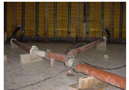
Pumpleitungen für SCC-Beton
