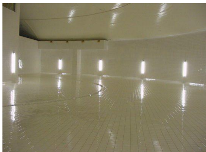
Reservoirkammer vor der Sanierung
