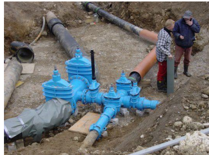
Leitungsanschlüsse NW 400/200/150
