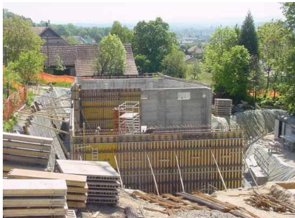
Betonieren Behälterwände
