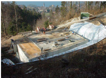
Baugrube und Rohbau
