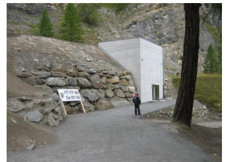
Das sichtbare Schieberhaus nach der Inbetriebnahme
