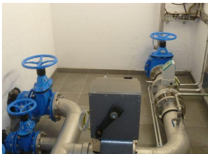
Komplett sanierter neuer Rohrkeller
