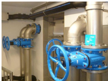
Neue Grossrohrinstallation aus Chromstahl und neue Drucktüren
