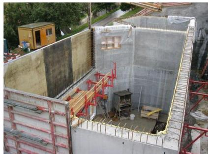
Reservoir – Betonarbeiten der Behälterwände
