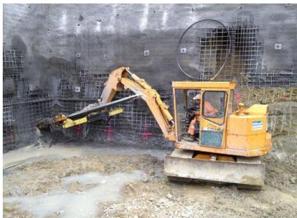
Reservoir – Ausführungsarbeiten Nagelwand
