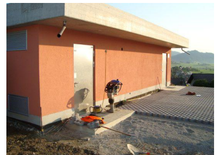
Schieberhaus mit Eingang Wasserversorgung (rechts) und Eingang BKW (links)
