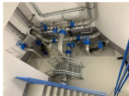
Neue Verrohrung und Armaturen im Schieberhaus
