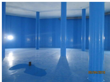
Neue Behälterbeschichtung (PE-Platten) in der grossen Kammer
