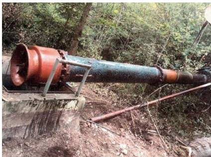
Entfernen der Rohrinstallationen in den Fassungsbrunnen
