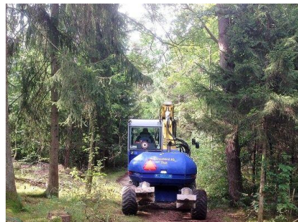
Platzverhältnisse Zufahrt Fassungsbrunnen
