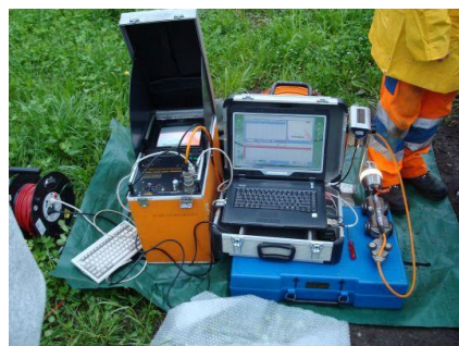
Voruntersuchung der Fassungsleitung mit Kanalfernsehen
