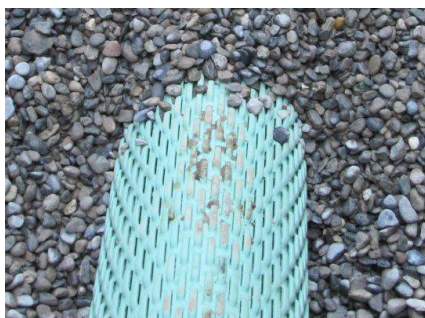
Neues Fassungsrohr Schlitzbrückenrohr
