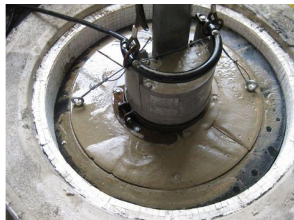
Entsanden bestehender Brunnen
