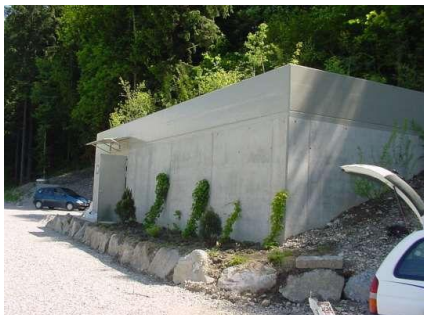
Fertige Brunnstube mit Bepflanzung Fassade
