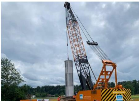
Einbau Vertikalbrunnen Wickeldraht-Filterrohr (DN 1200, Schlitzweite 2.5mm)
