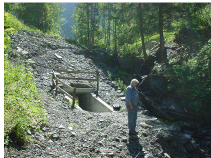
Der Eingangsbereich zur Brunnstube wurde erdüberdeckt und mit einem Holzzaun gesichert
