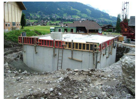
Gebäude im Rohbau
