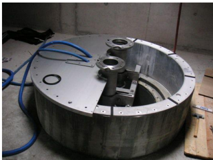
Einbau Pumpen, Steigrohre, Brunnenkopf
