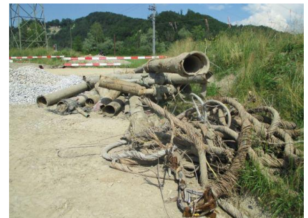
Alles alte Rohr- und Kabelmaterial im Fassungskreislauf wurde ausgegraben und entsorgt
