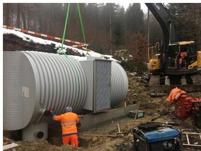
Versetzen Sammelbrunnstube
