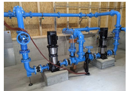
Stufenpumpen (Fördermenge: 540 l/min)
