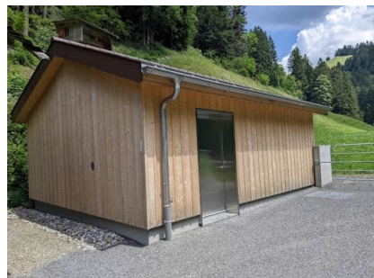
STPW Senggen aus Holzrahmenkonstruktion
