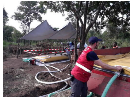
Befüllung des mobilen Trinkwasserreservoir (5'000 l) mittels Lastwagen
