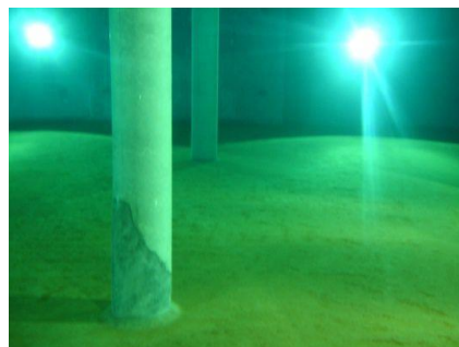
Sämtliche Anlagen wurden besichtigt und dokumentiert
