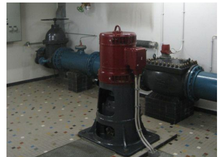
Bestehende Sulzer-Bohrlochpumpe
