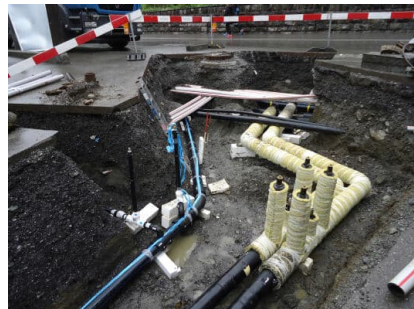
Einbindung der neuen Leitungen in das bestehende Netz inkl. Dehnungsschenkel. Entlüftungsarmaturen in den Fernwärmeleitungen.
