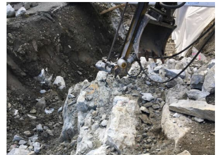
Grosser Findling im Grabenbereich
