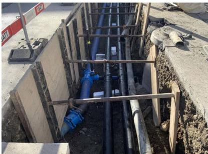
Offener Graben mit neu verlegten Trinkwasser- und Fernwärmeleitungen
