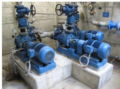
Effizienzpotential: alte Betriebswasserpumpen mit zu hohem Druck und zu kleinem Speicher ersetzen.
