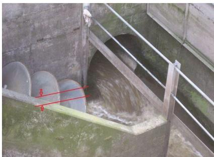
Effizienzpotential: Einstauhöhe beim Einlauf des Schneckenpumpwerks anpassen.
