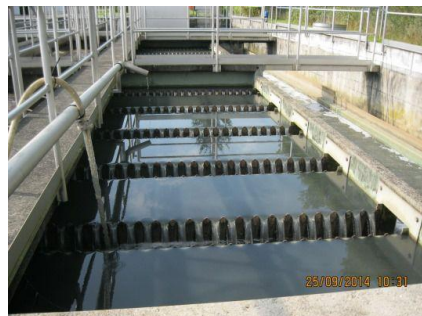
Betriebsoptimierung von Lamellenabscheider, Schlammwasserpumpen und -Rührwerk
