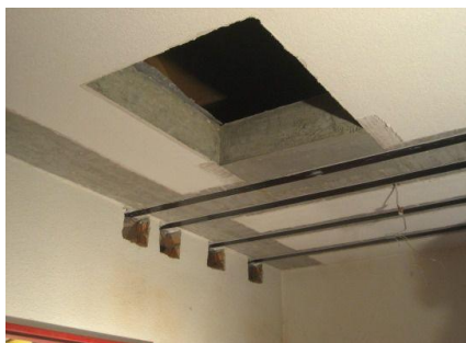
Einbau von CFK-Lamellen zur Deckenverstärkung vor Ausschneiden der Decke
