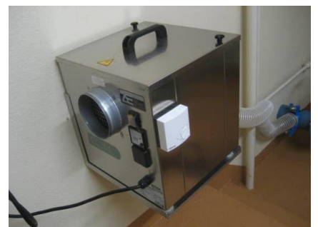
Adsorptionstrockner anstelle Elektroheizung
