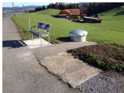
Neue Brunnstube (Wasserschloss)
