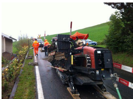
Spülbohrung Leitungsbau
