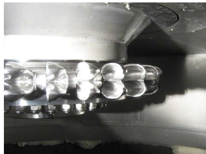
Einbau des Turbinenrades
