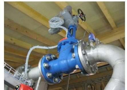
Hauptsperrschieber PN 64 bar
