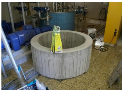
Fertig betonierter Turbinensockel
