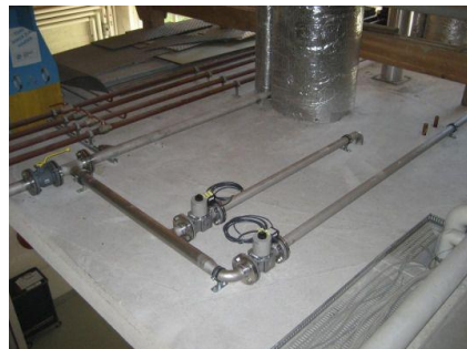
Umbau und Nachrüstung der Gaszufuhr mit Haupt- und Sicherheitsventilen
